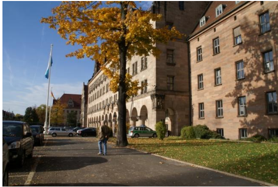
© Cöster & Partner Justizpalast Fürther Str. 110, Nürnberg; Sitz des Amtsgerichts Nürnberg, des Landgerichts Nürnberg-Fürth und des Oberlandesgerichts Nürnberg
